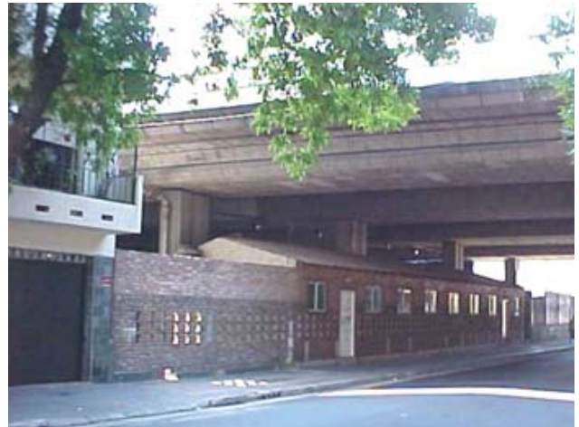
Autopista 25 de Mayo, atravesando la calle Pichincha al 1300.
